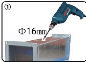
在排风管上打一个直径16mm的孔
