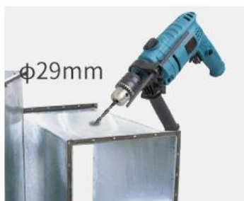
① 在排风管上打一个直径29mm的孔
