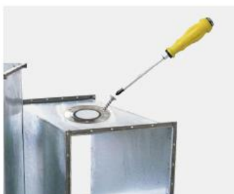
② 用螺丝将法兰盘固定在排风管上
