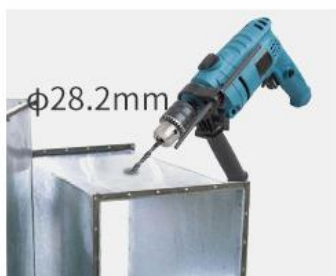
① 在排风管上打一个直径28.2mm的孔
