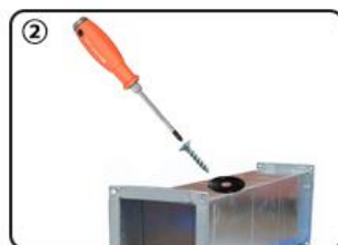
用螺丝将法兰盘固定在排风管上
