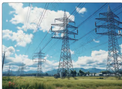
电网铁塔、通讯铁塔安全监测
