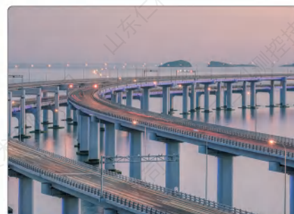
桥梁桥塔监测
